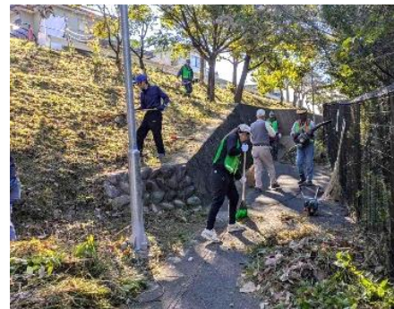
ロードサポーターによる 2丁目遊歩道の除草活動
