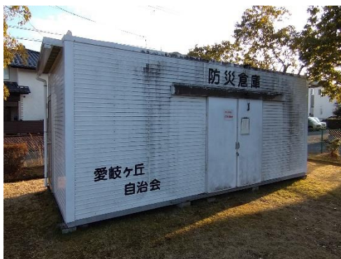
4丁目防災倉庫
