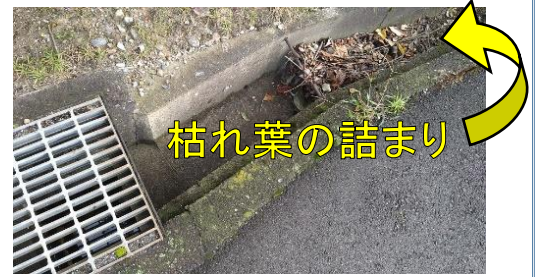
側溝の掃除も大切です。
