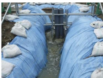
素掘水路で近傍水路へ導水した事例（青森県馬淵川流域）
