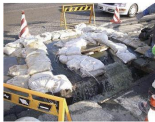
土のうを使用し近傍水路へ導水した事例（宮城県多賀城市）
